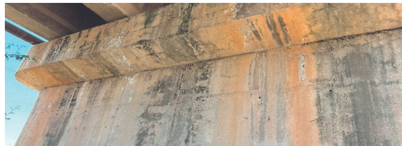
Figura 1. Concreto dañado.
