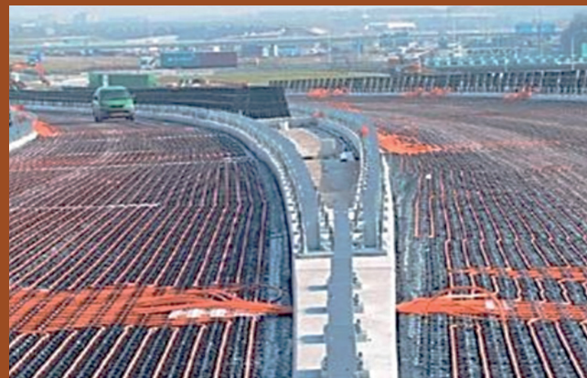
Figura 1. Colector asfáltico en Rotterdam de Bondt & Jansen (2006).
