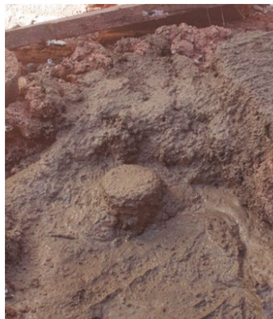
Figura 2. Micropilote ya colocado en el concreto o mortero de 250 kg/cm 2 .
